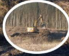
河川の改良工 をしている重機が 動いてました ▶
