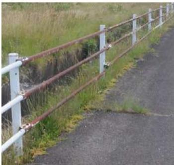
サビてしまっている歩道の防護柵を新しいものに交換する工事です。水路脇で雑草が生え放題だったため、草が生えてこないように、表面をアスファルト舗装で仕上げました。柵も3段から4段に増えて安心ですね！
