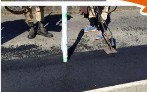
▲機械が入らないので、人の手で舗装しています。熱々の材料(合材)を敷いて、転圧すると、アスファルト舗装の完成です。(寒いと冷えて難しいんです…)
