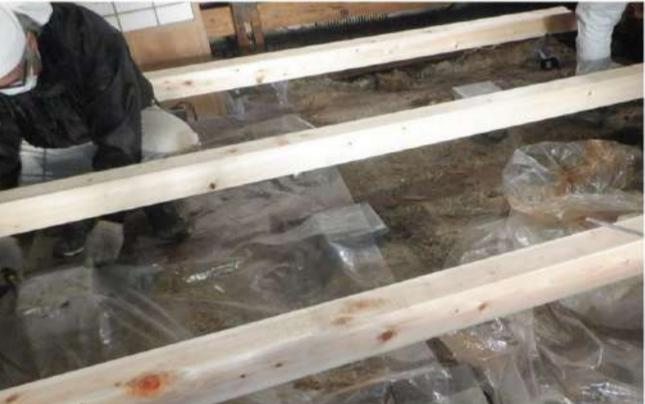
これは床の修繕工事をしているところです。傷んだ下地を交換し、土間シートを貼って、鋼製の束を入れたら断熱材を入れて床を貼っていきます。木材にはシロアリ防止の薬剤を塗っています。
