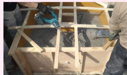
↑『生コン』を型枠に流し込みます。
