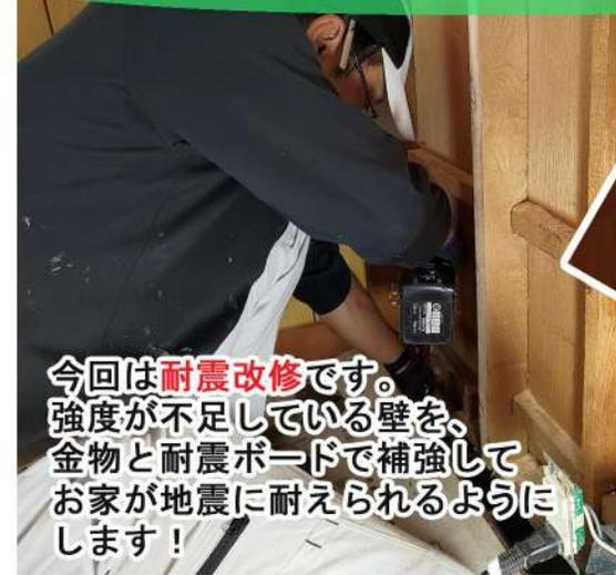
今回は耐震改修です。強度が不足している壁を、金物と耐震ボードで補強してお家が地震に耐えられるようにします！
